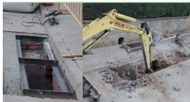
1 OBRA VIA DR. TARRUELLA
